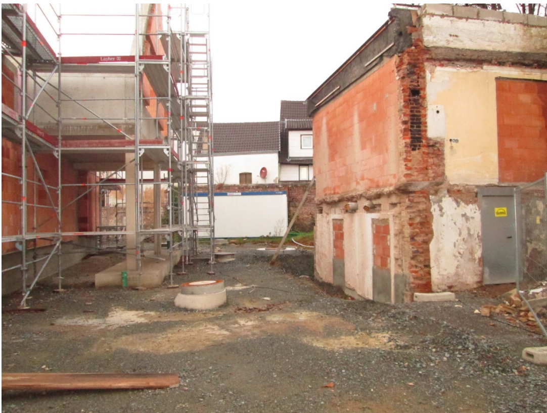
Aktuell rückwärtige Ansicht großer Saal Alter Rodensteiner/ehem. WC-Anlagen (rechts) und KiTa-Rohbau links Foto: Kommune
