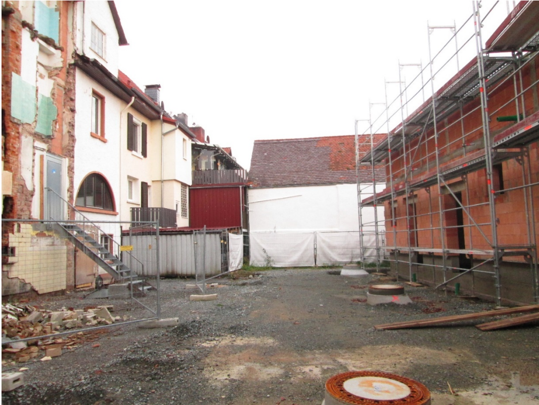
Aktuelle Ansicht rückseitige Außenfassade Alter Rodensteiner (links im Bild) KiTa-Rohbau rechtsseitig. Foto: Kommune
